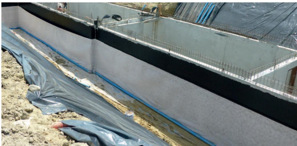
Optimale Lastverteilung bei zusätzlicher Drainagefunktion.
