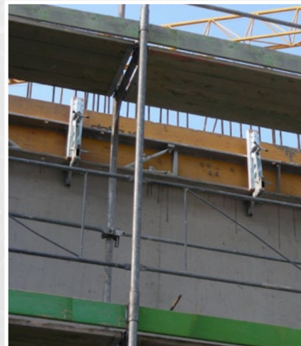
BKA Pro Konsole 30 cm im Einsatz bei Fassadengerüsten
