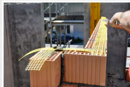
Wall-Grip wird mittig auf die Lagerfuge ausgerollt und einfach übermauert
