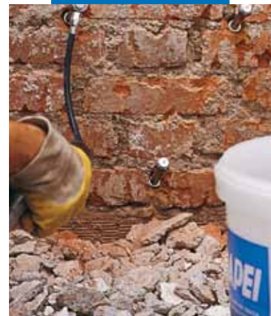
Injizieren mit Niederdruckpumpe
