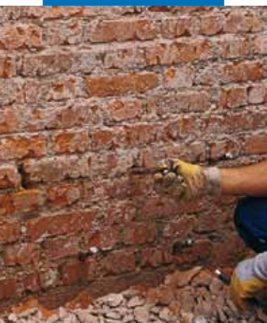
Einführung der Injektionsvorrichtung in Bohrloch
