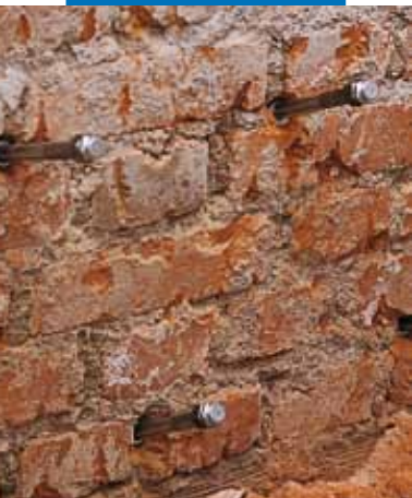
Injektionsvorrichtung im Detail
