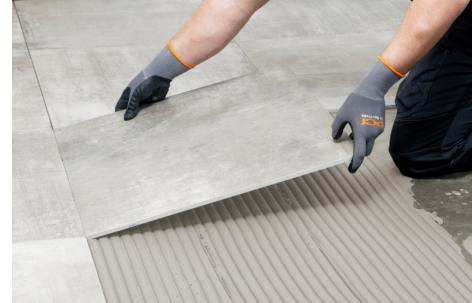
PCI Nanorapid verfügt über eine lange Verarbeitungszeit in Verbindung mit einer punktgenauen schnellen Abbindezeit
