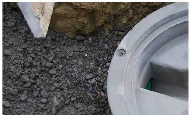
Bild 31: Umhülltes Anschlussrohr
