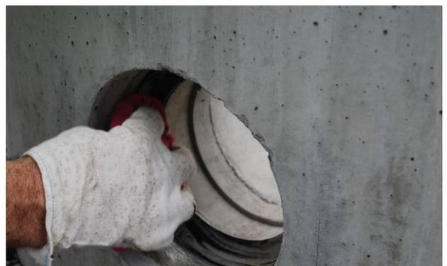
Bild 29: Dichtring mit geeignetem Gleitmittel einschmieren
