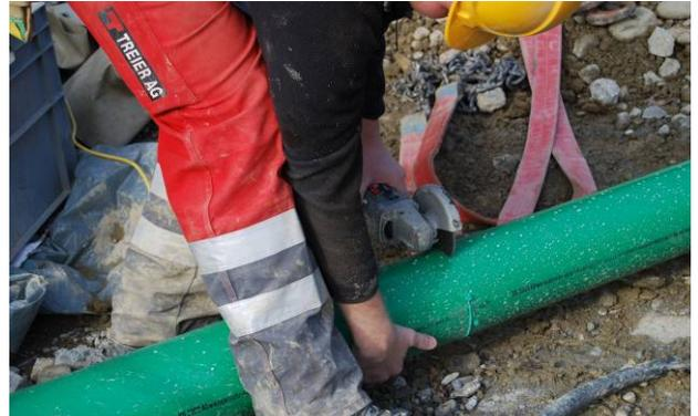
Bild 26: Ablängen des Kunststoffrohres
