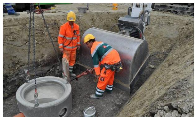
Bild 25: Zusammenzug mit Stockwinde
