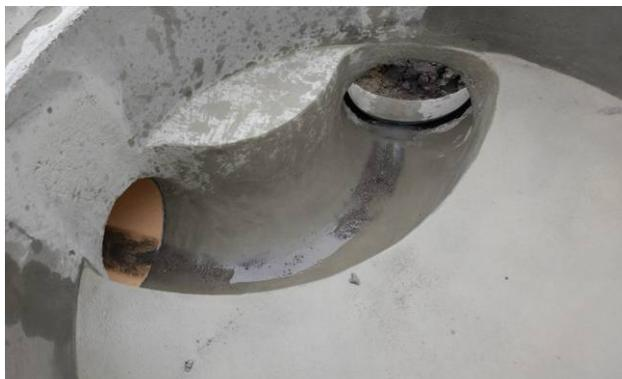
Bild 2: CRENO Normschachtboden gefräst
