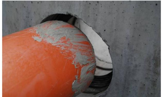
Bild 30: Zentrisches Ansetzen des Kunststoffrohres
