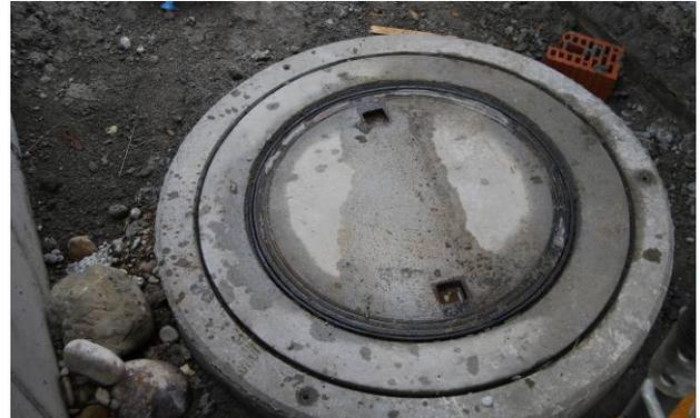
Bild 34: Aufsetzen eines Betondeckels mit Kontrollöffnung bei zu geringer Schachthöhe
