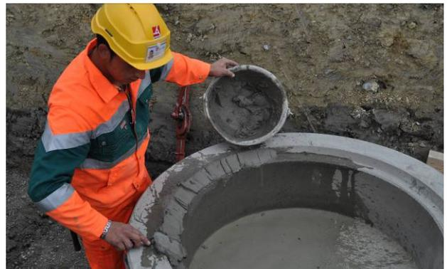
Bild 32: Aufbringen einer Frischmörtelschicht
