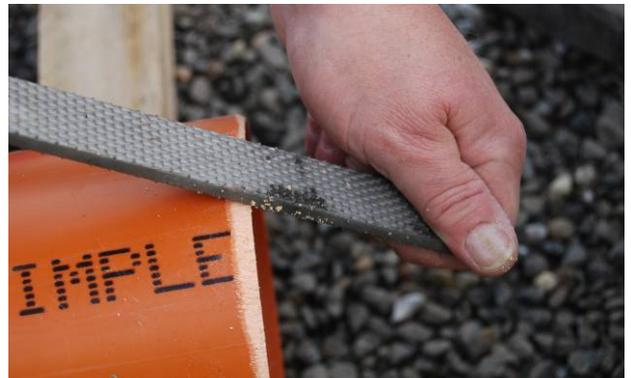
Bild 27: Anschleifen des Rohres
