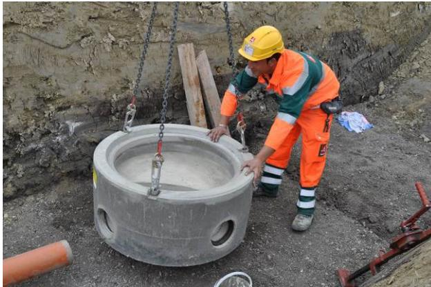
Bild 19: Interner Baustellentransport mit geeignetem Hilfsmittel
