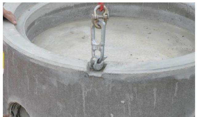
Bild 18: Werkseitig eingebaute Kugelkopftraganker mit Kupplung
