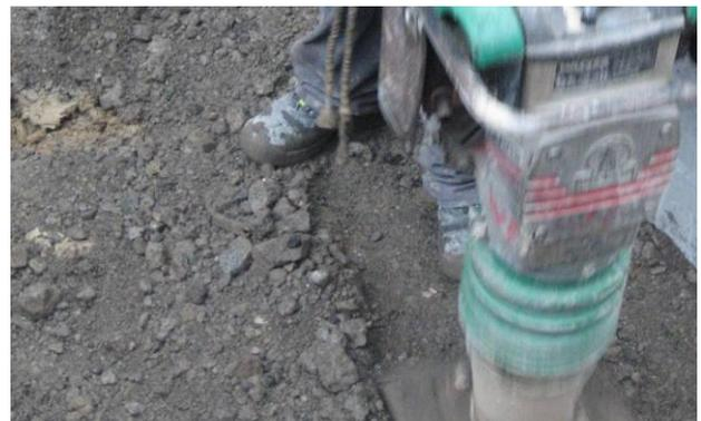
Bild 35: Lagenweises Einbringen und Verdichten des Auffüllmaterials
