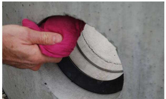
Bild 28: Reinigen des Dichtringes
