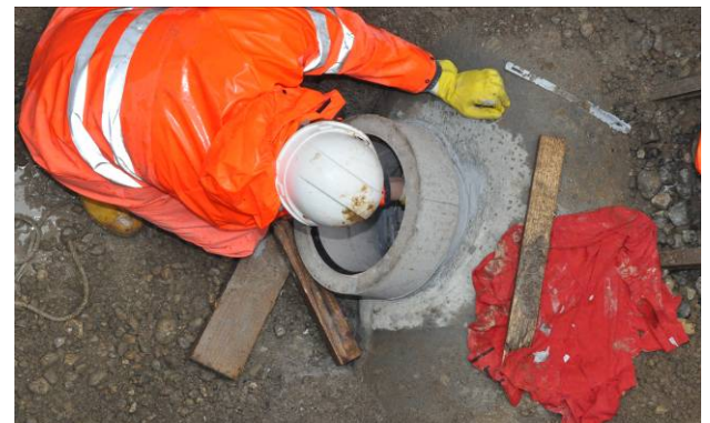
Bild 12: Innenkante von Hand modellieren und Reste entfernen
