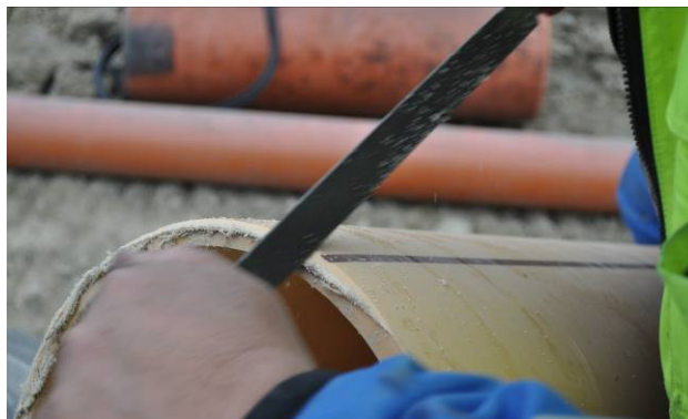
Bild 14: Anfasen des Kunststoffrohres, reinigen und einschmieren
