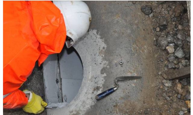
Bild 10: Klebmasse auf die Bohrlochwandung auftragen
