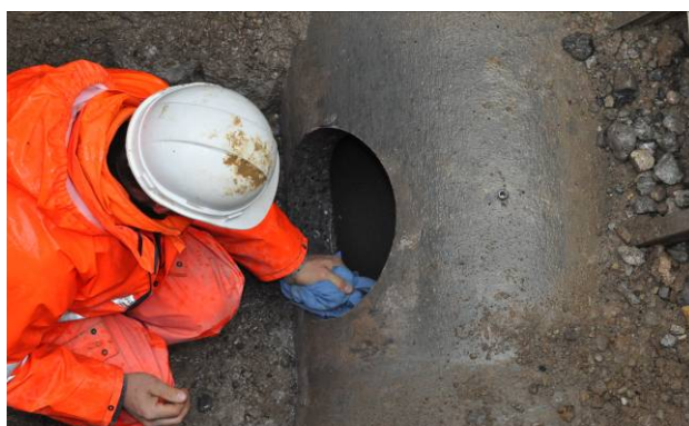
Bild 7: Bohrloch reinigen
