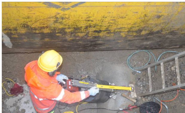
Bild 6: Korrekt montiertes Kernbohrgerät
