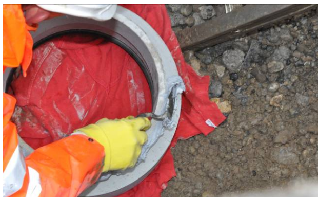
Bild 9: Auftragen der Klebmasse auf den Schaft
