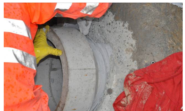
Bild 13: Bilden der äusseren Kehlkannte
