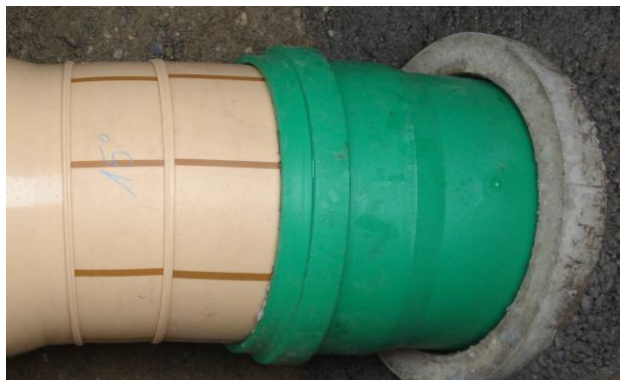
Bild 15: Angeschlossenes Anschlussrohr
