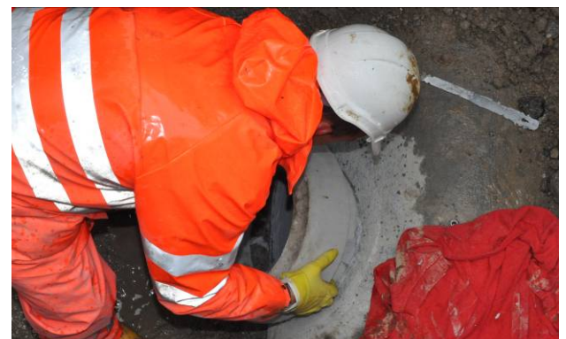
Bild 11: Klebeanschlussstück mit einer Drehbewegung einsetzen
