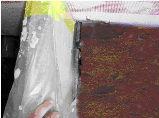
Bild 37: Trennfolie zwischen Hinterfüllung und Lichtschacht
