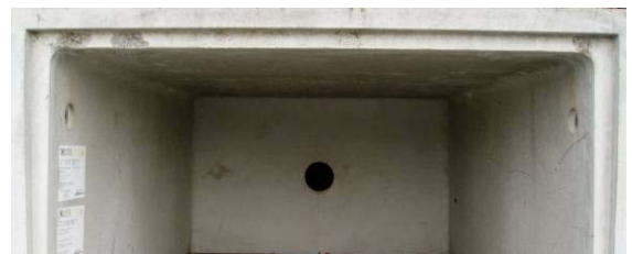
Bild 28: Lichtschachtsohle mit eingebautem Boden
