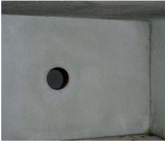
Bild 5: Lichtschacht mit Boden
