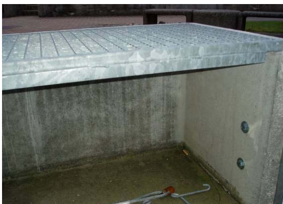
Bild 39: Verstärkte Gitterrostkante gegen die Hauswand
