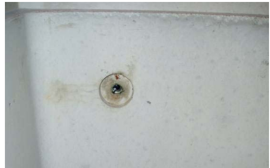
Bild 23: Eingelegte Gewindehülse M 12 oder M 16 für Transport und Montage
