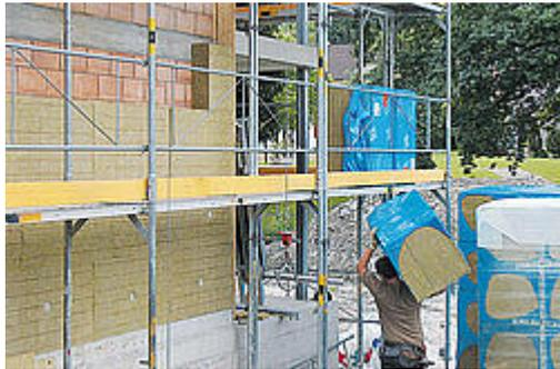
Zweischichtige Dämmplatte mit elastischer Innen- und härterer Aussenschicht für vollflächige Dämmungen in hinterlüfteten Fassaden, sowie Kerndämmungen in Zweischalen-Sichtmauerwerken.
